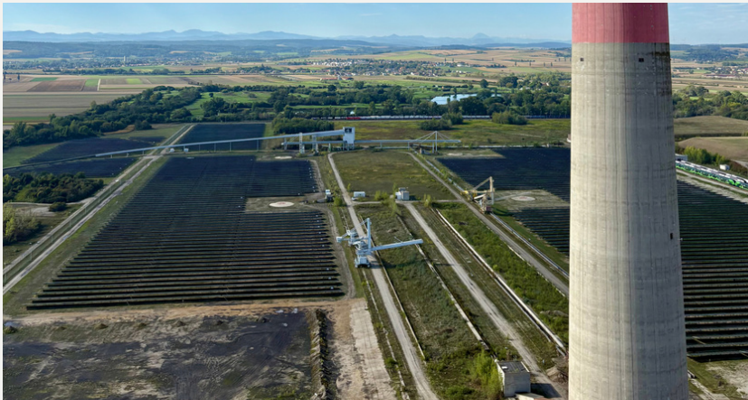
Wo früher der Kohlevorrat für eineinhalb Jahre gelagert wurde, steht heute eine Photovoltaik-Anlage mit 25 MWp Leistung, eine weitere ist in Planung.
